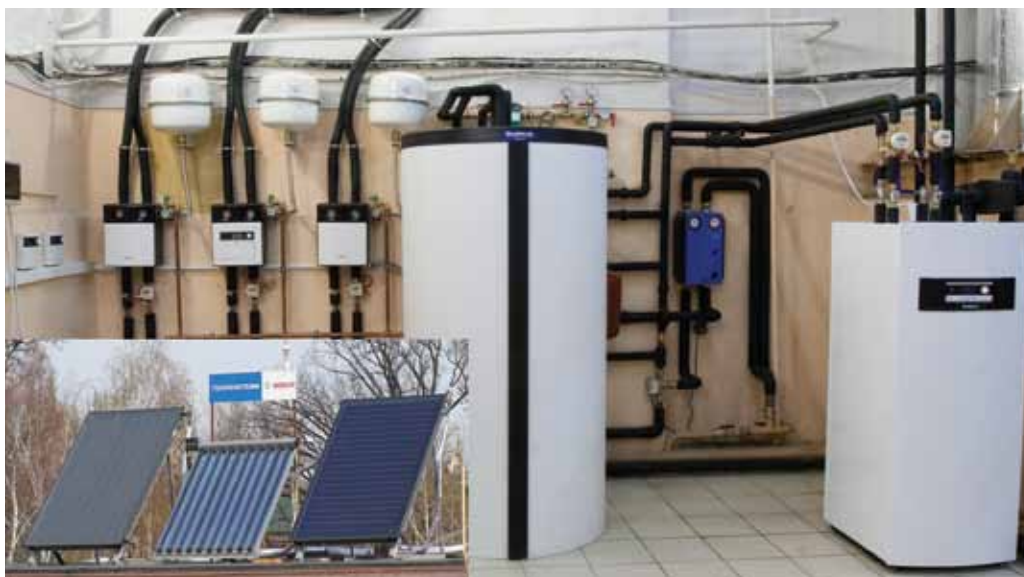
❖ Рис. 1. Стенд «Возобновляемые источники энергии».
